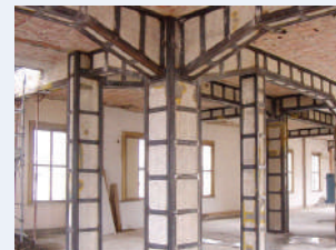
ADEGUAMENTO SISMICO EDIFICIO
